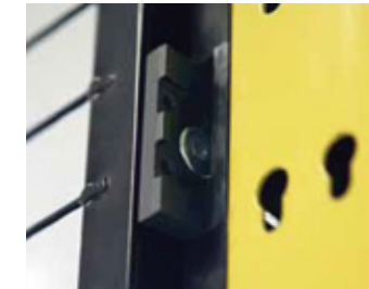
柵の内側からのパネルの 取り付け、取り外しが可能。
